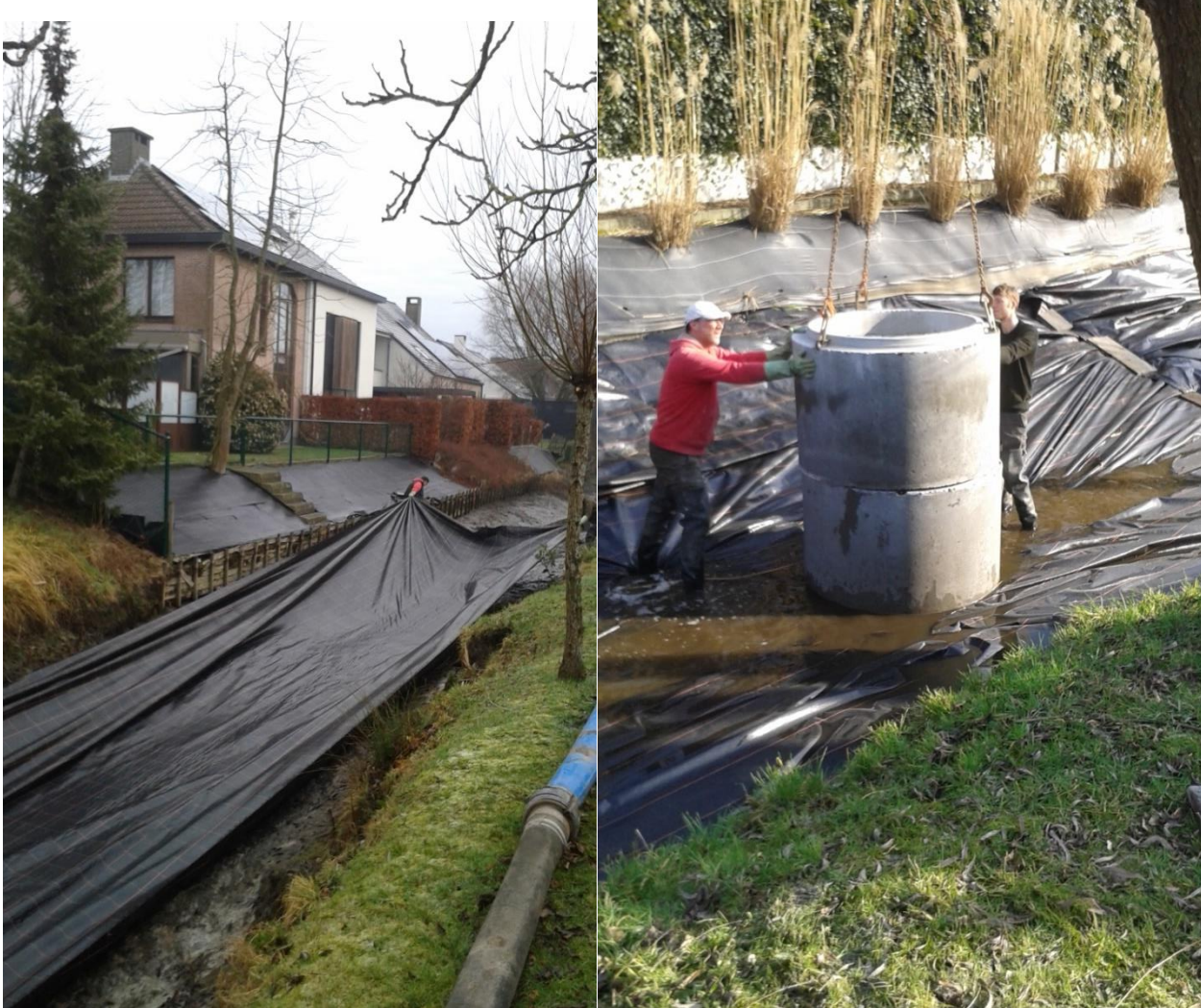
Februari 2019 plaatsen van de folie en de ringbuizen (controle) er op.
